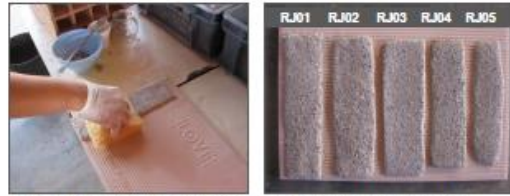
Figura 2. Aplicação das argamassas de substituição nos painéis experimentais. (Legenda: RJ: refechamento de juntas)
