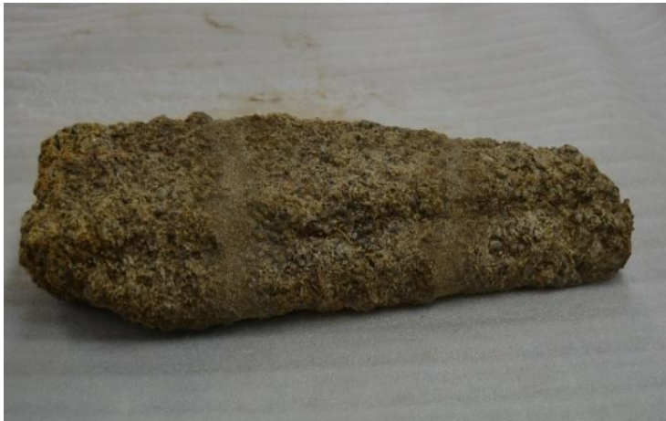
Fissuras refechadas com argamassas de cal
