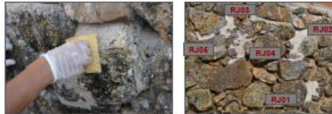
Figura 3. Aplicação das argamassas de substituição numa parede exterior às ruínas com características semelhantes.
